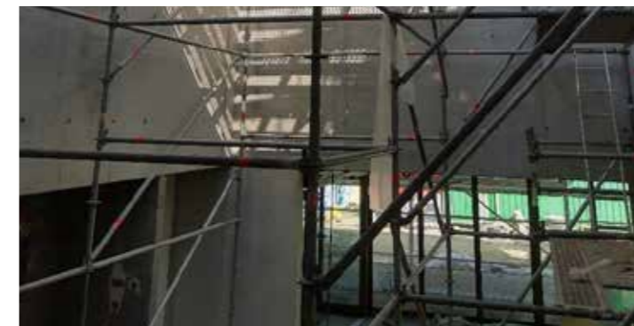
Alle resterende beglazing wordt geplaatst
