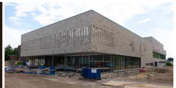
De laatste buitenmuren worden opgevoegd
