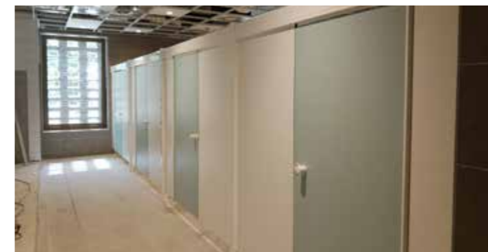
De kleedkamers worden geplaatst
