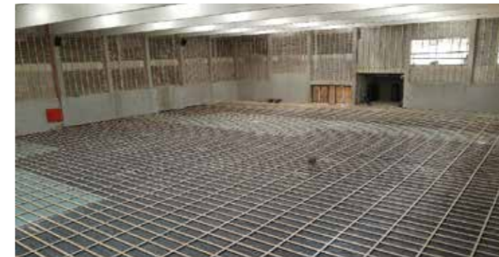
De sportvloer in de sporthal wordt geplaatst - op de foto links is de houten onderconstructie zichtbaar
