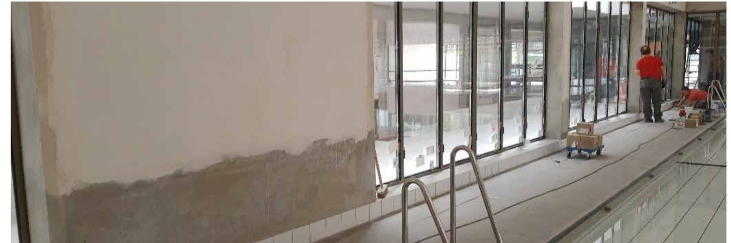
Alle ramen rond het zwembad zijn geplaatst
