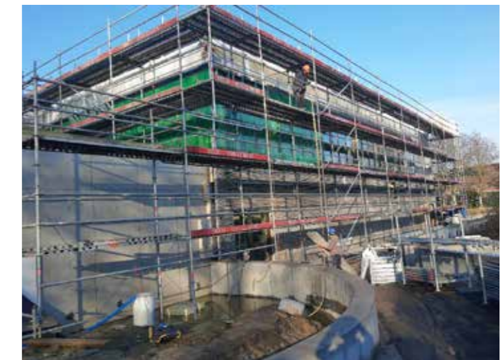
De buitenmuren worden verder opgemetsd.
