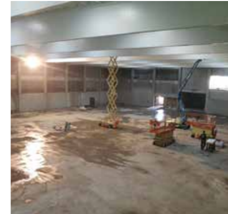
De chape in de sporthal wordt de volgende weken gegoten. De sportvloer in de sporthal wordt eind april geïnstalleerd.
