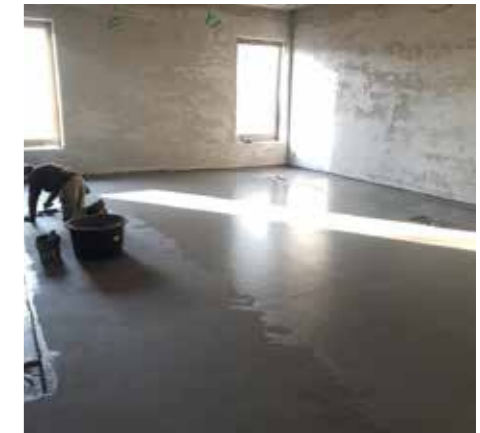
De vloeren in het zwembadgedeelte worden voorbereid voor verdere afwerking.
