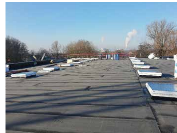
Het dak is helemaal dichtgemaakt en de lichtkoepels zijn geplaatst.
