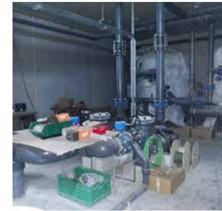
Het zwembad zal worden gevuld voor een controle van de systemen.
