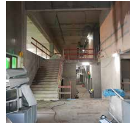
De chape in de gangen, kleedkamers, burelen en cafetaria werd reeds gegoten.
