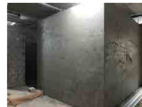
De wanden in de vochtige ruimtes (o.a. kleedkamers zwembad) worden in december gecementeerd.
