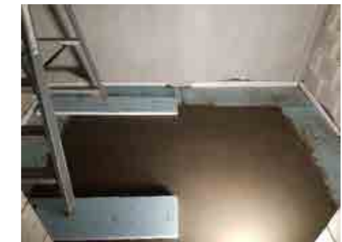
De chapewerken zijn in de eerste helft van december afgewerkt.
