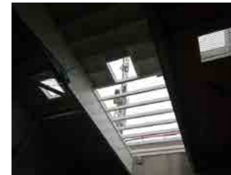
De lichtkoepels werden reeds op hun plaats gezet in de dakconstructie.
