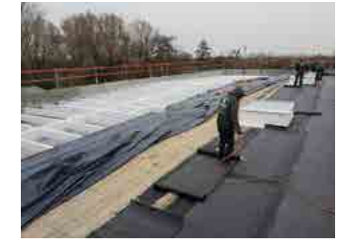
Het dak van de sporthal wordt momenteel helemaal dichtgelegd en waterdicht afgewerkt.
