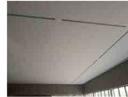
Het verlaagde plafond in het zwembad werd ondertussen verder afgewerkt.
