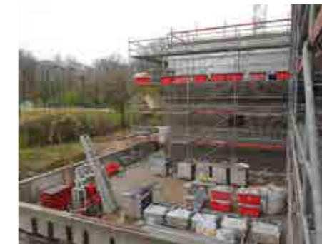
Het metselwerk van de buitenmuren wordt verder afgewerkt.
