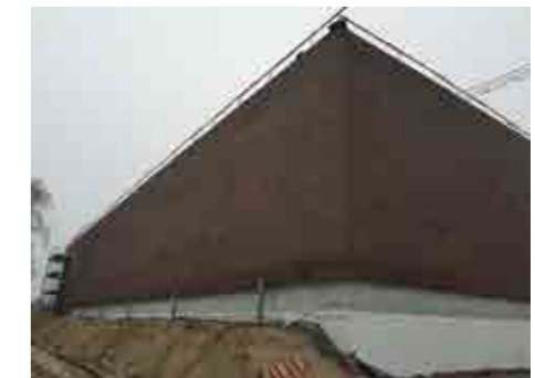
De achtergevel is al helemaal tot boven opgemetst.
