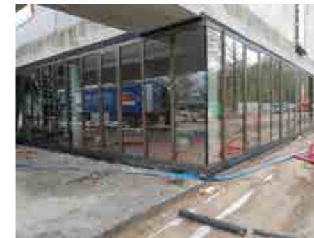
Het schrijnwerk buiten is zo goed als allemaal geplaatst.
