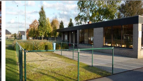
Kleedruimte en kantinegebouw
