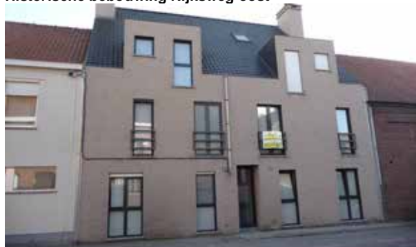
Historische bebouwing Rijksweg oost
